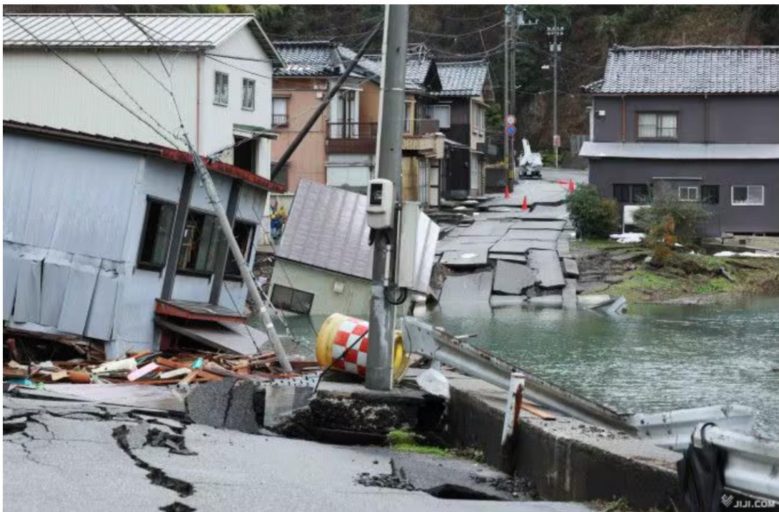
地震と津波で破壊された道路 = 2024年1月9日、石川県能登町
