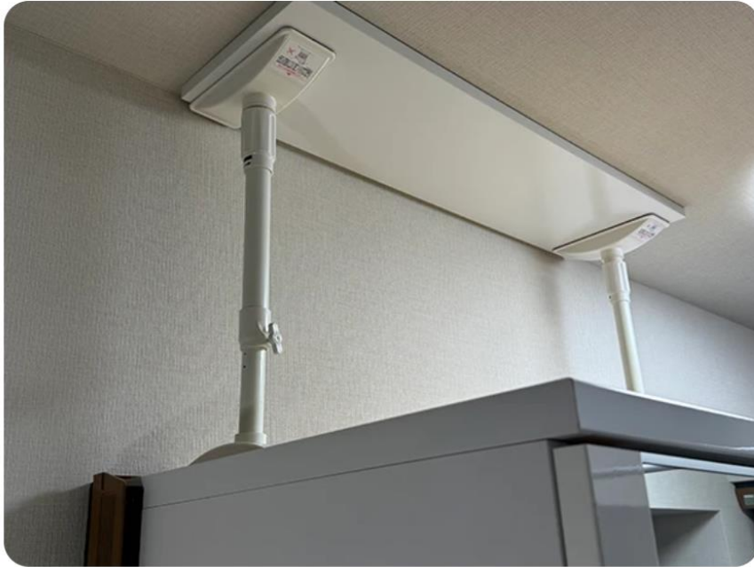
天井補強で家具固定（筆者撮影）
